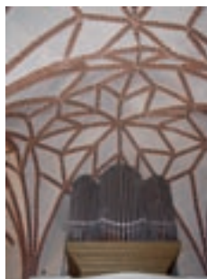
Kleczew. Żebrowane sklepienie w kościele św. Jakuba.
